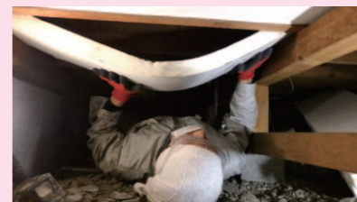
既存床下からの根太間への断熱ボード施工例
