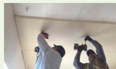
既存天井への断熱複合パネル上張り施工例
