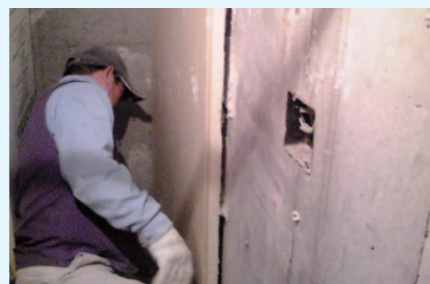
コンクリート壁への断熱複合パネル施工例
