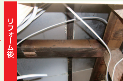
屋根裏面への断熱ボード施工前後例
