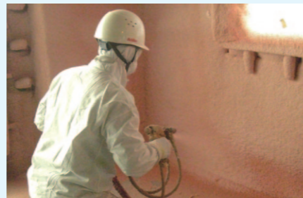
コンクリート壁への現場発泡ウレタン施工例
