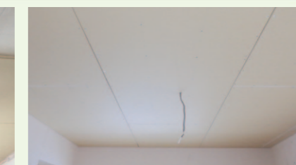
既存天井への断熱複合パネル上張り施工例
